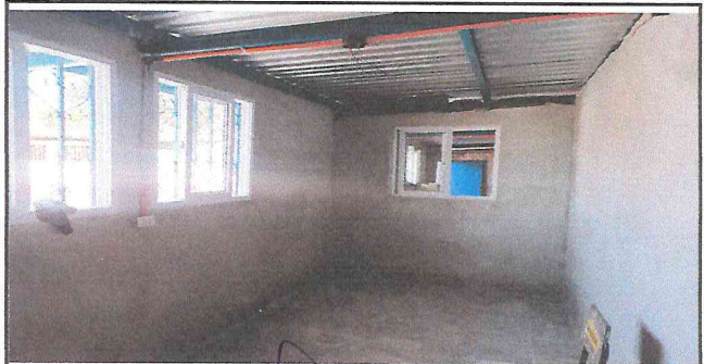
sustitución de trota de cemento por piso cerámico
