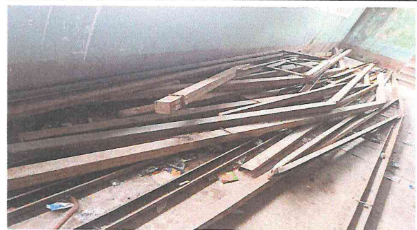
Foto 4: estructura retirada para su mantenimiento
