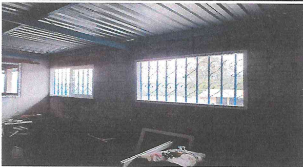
Foto 5: balcones Y VENTANAS REMOZADAS
