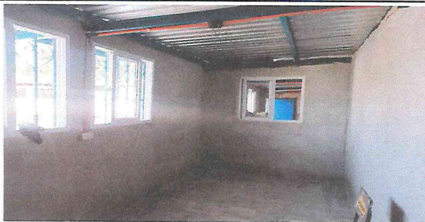
Foto 3: techo de aula REMOZADO Y PINTADO SUSTITUTO DE MADERA POR METAL
